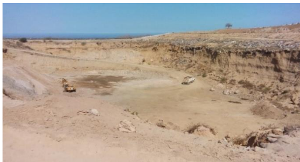
[Fotografía de Karina Osuna]. ('Celda de confinamiento en construcción para RSU' del sitio controlado 'La Candelaria', Cabo San Lucas, 2020).
