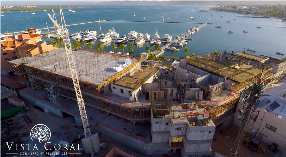
Avance de obra enero 2019
