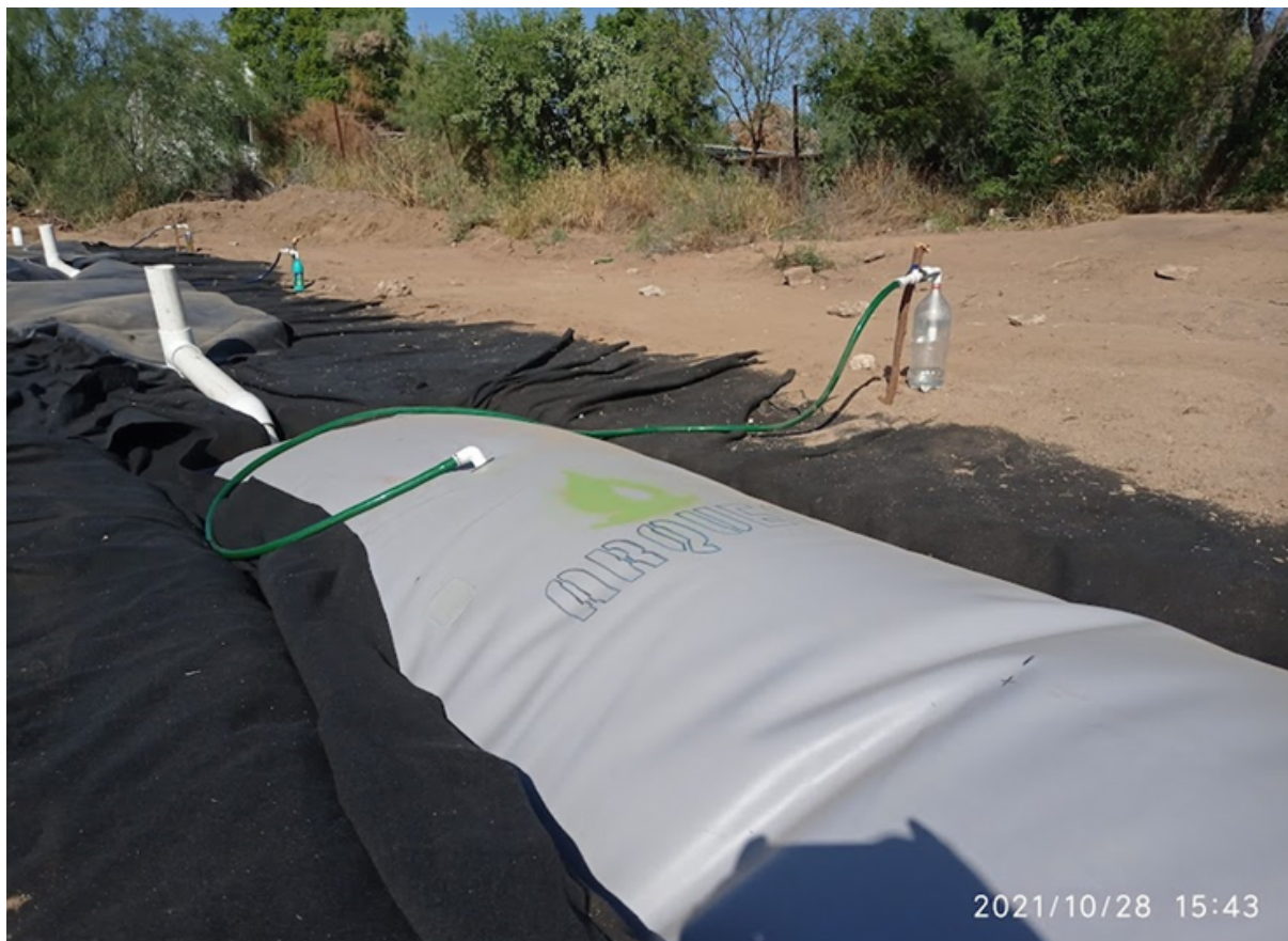
Figura 3. Biodigestor tubular construido con geomembrana de PVC, instalado en la posta porcina de la Universidad Autónoma de Baja California Sur. Archivo personal.
